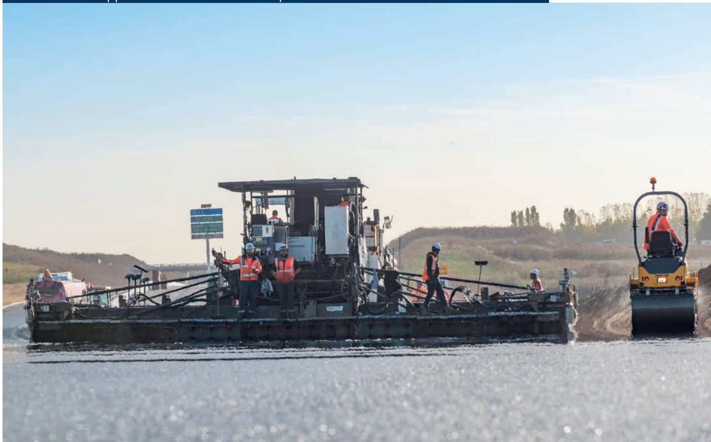
Octobre 2022 - Application des enrobés sur la phase 2 du CER entre le Mesnil-Amelot et l'A1
