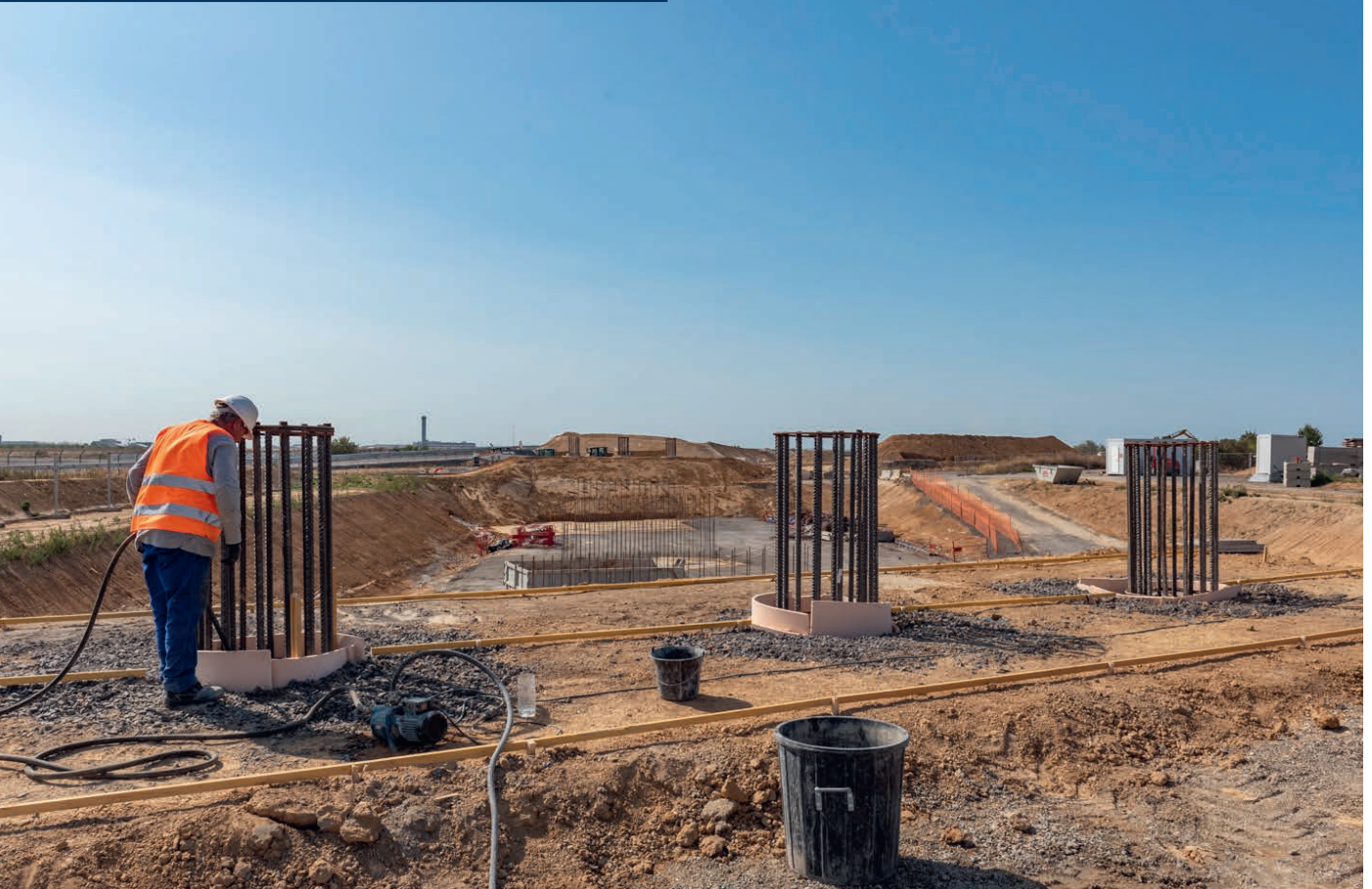
Septembre 2020 - Fondations du pont de Mauregard (PS9)
