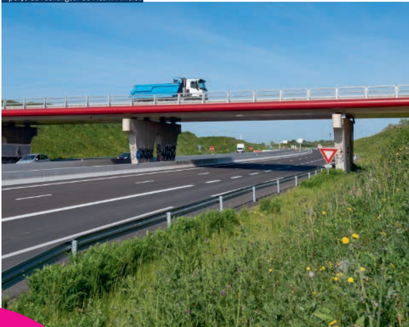
Aperçu de l'échangeur du Mesnil-Amelot
