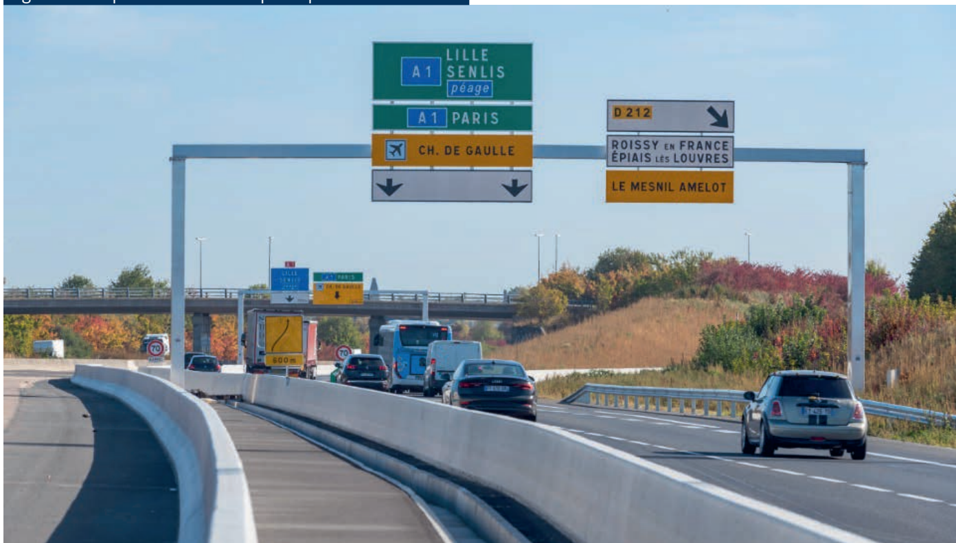
Signalisation provisoire mise en place pendant les travaux
