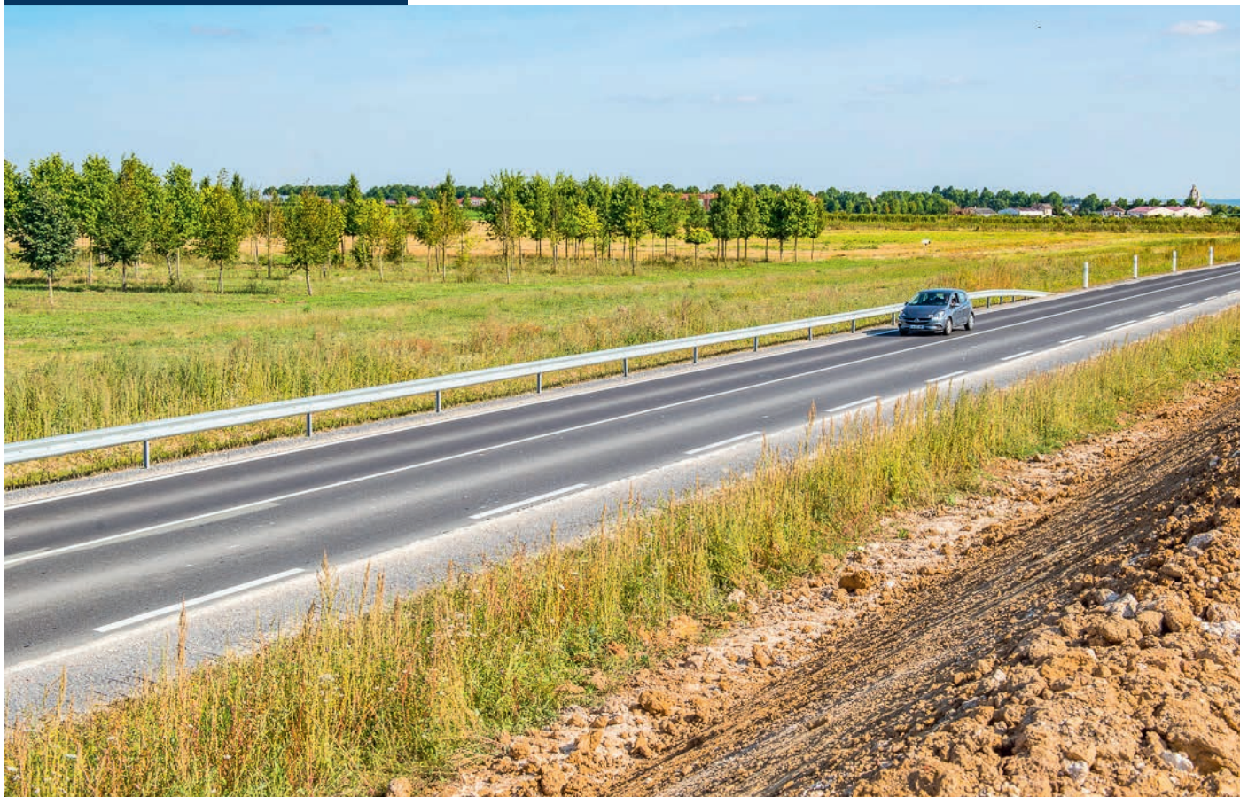
Août 2021 - RD212 achevée et circulée
