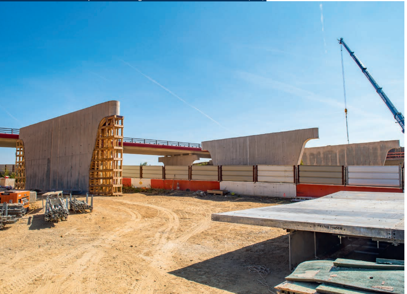
Août 2021 - Élévation des piles de l'ouvrage de doublement de l'accès Est (PS6)
