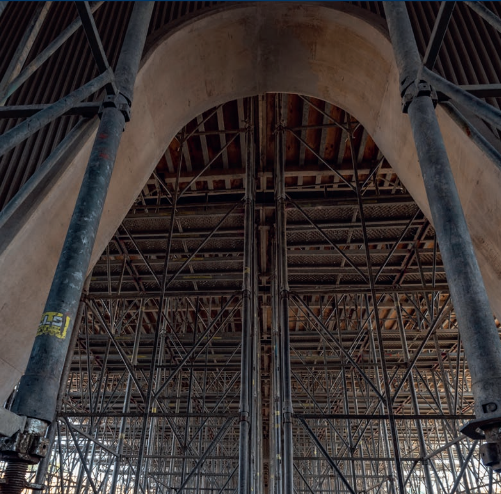
Novembre 2020 - Étaieage du tablier du pont de l'échangeur du Mesnil-Amelot (PS7)
